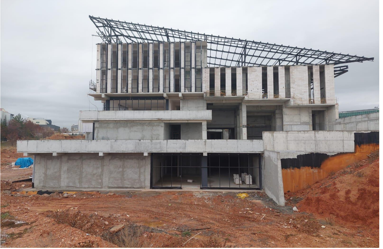
( Deri Tekstil Seramik Tasarım Merkezi Binası )
