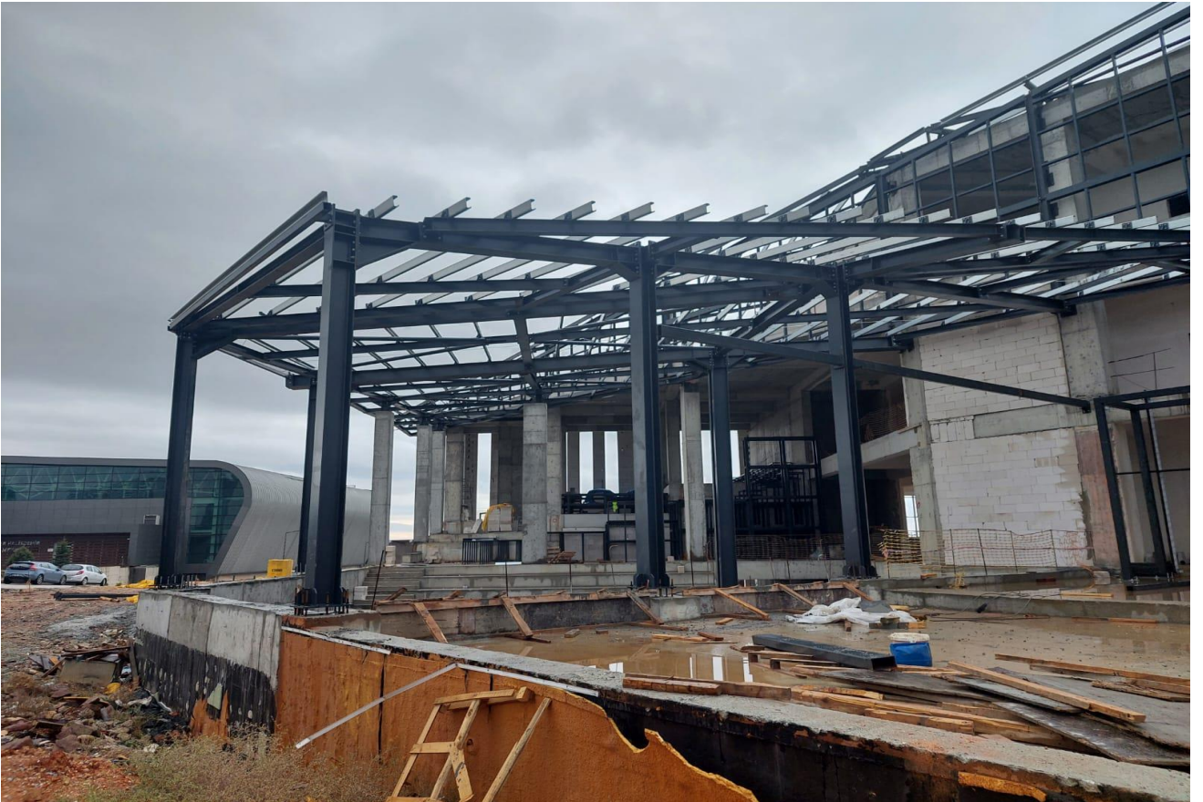
( Deri Tekstil Seramik Tasarım Merkezi Binası )
