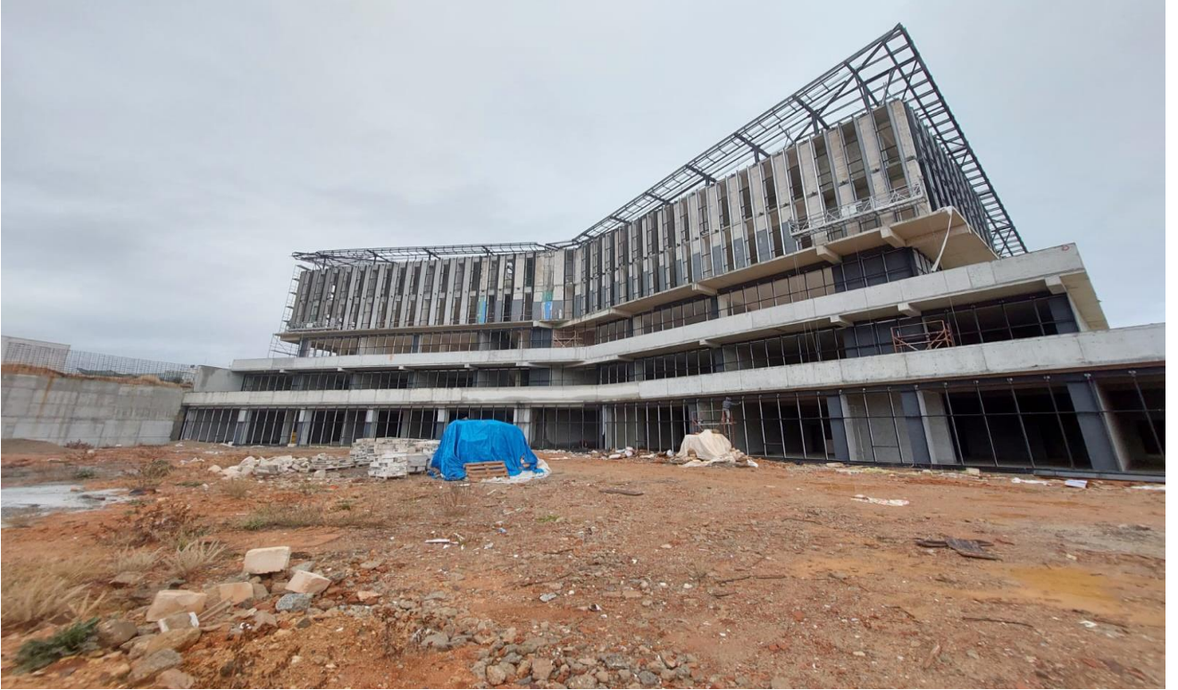
( Deri Tekstil Seramik Tasarım Merkezi Binası )
