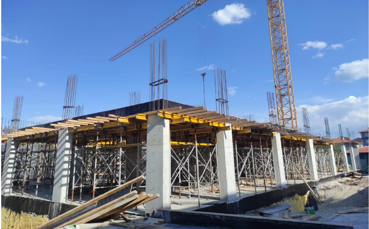
(Diş Hekimliği Uygulama ve Araştırma Hastanesi inşaatından bir görünüm)
