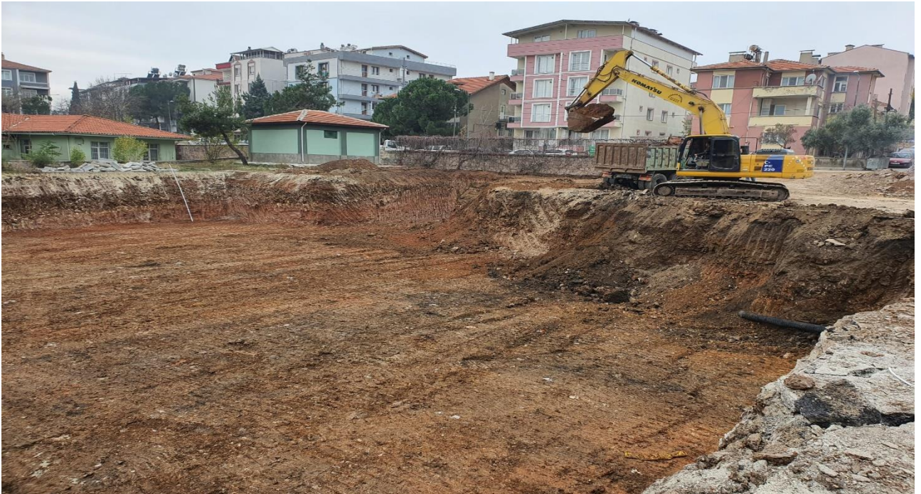
(Diş Hekimliği Fakültesi ve Diş Hastanesi Binası temeli)
