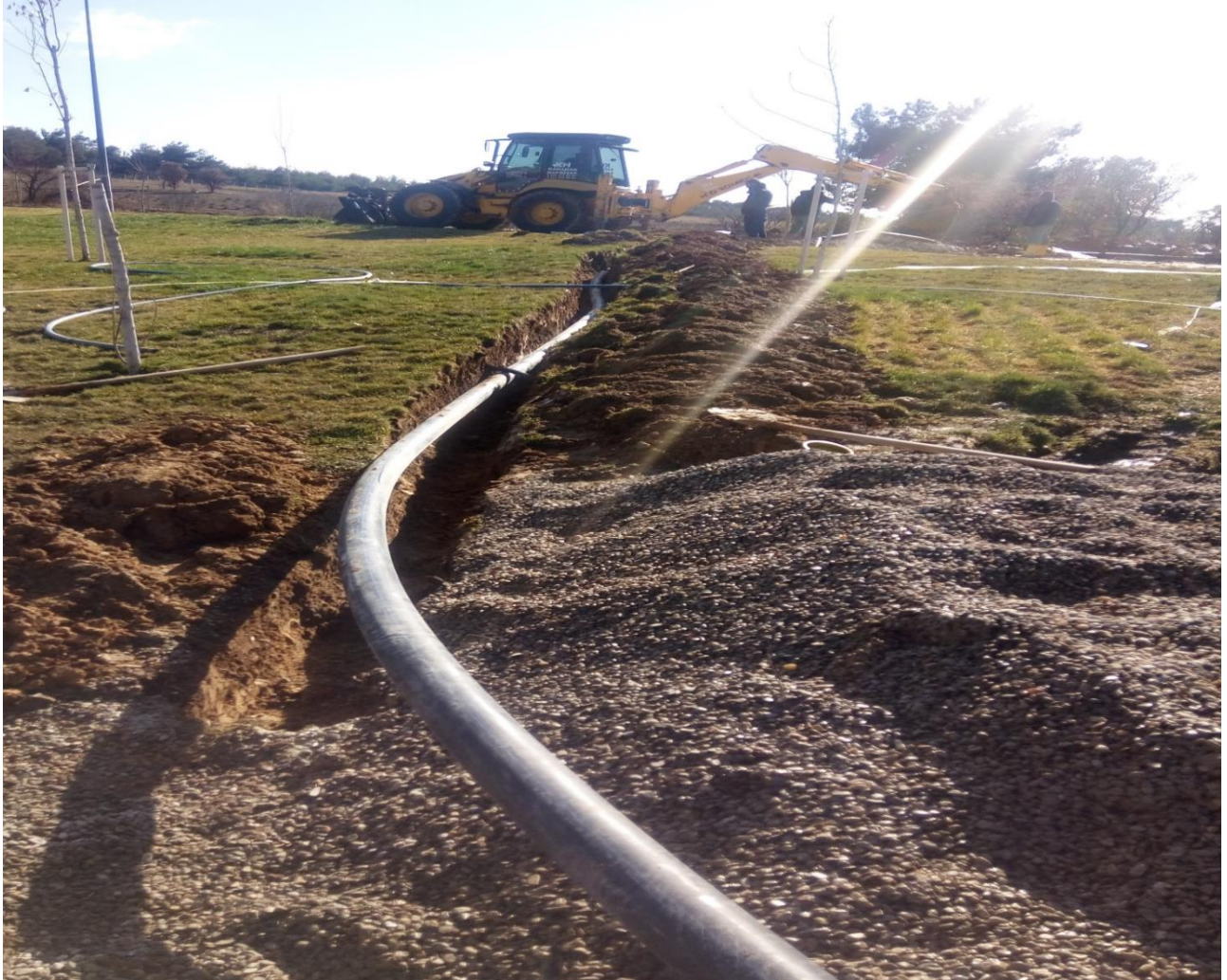
(Kampüs Altyapısı Projesi Kapsamında yapılan Spor Bilimleri Fakültesi ve Su Deposu Arasındaki Elektrik ve Su Hattı Bağlantıları)
