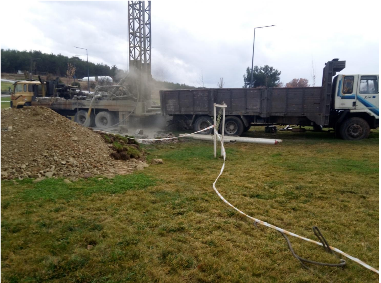
(Kampüs Altyapısı Projesi Kapsamında yapılan Spor Bilimleri Fakültesi Yeraltı Su Kuyusu Sondaj)
