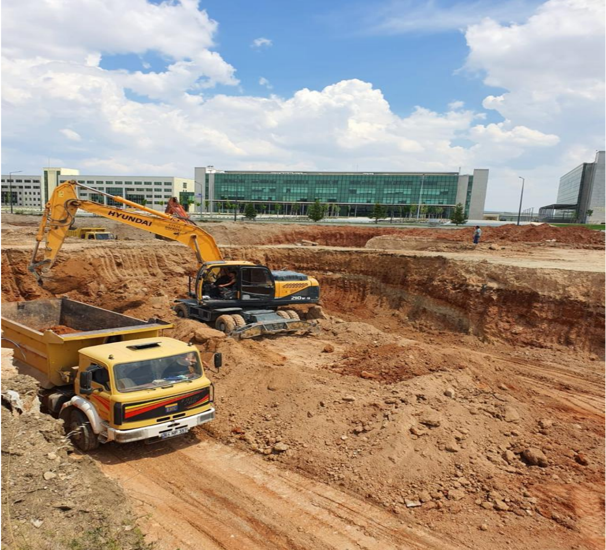
Tasarım Merkezi Binasının temel kazma çalışmasından bir görünüm.
