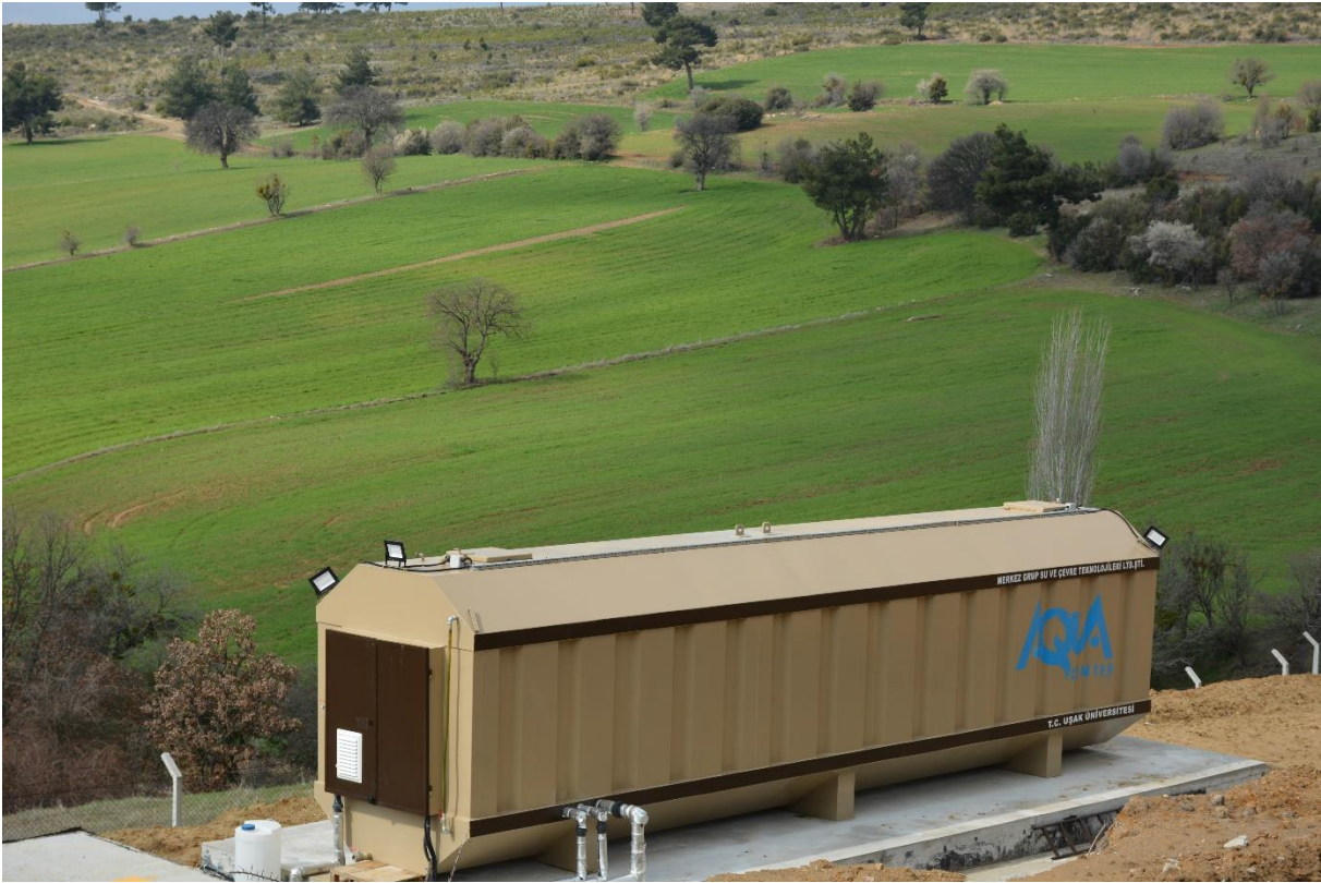
Spor Bilimleri Fakóltesi ve Sentetik Atletizm Pistli Futbol Sahası Eysel Paket Atıksu Arıtma Tesisi işinden bir görünüm.
