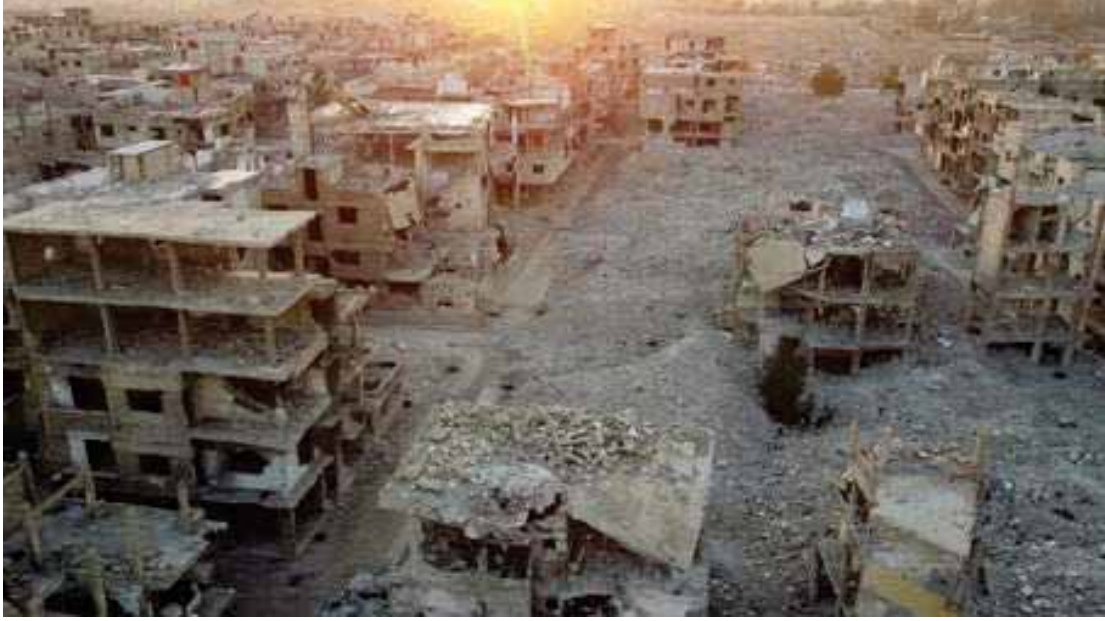
الدمار الذي لحق بمخيم اليرموك. الصورة: TíHEK، ٢٠٢٥.
