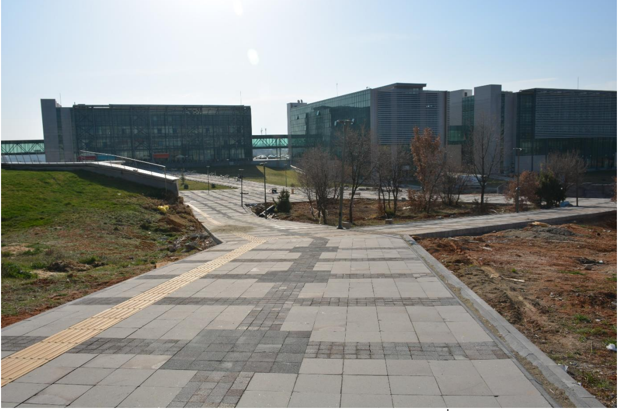
Kampüs Altyapı Projesi Kapsamında Yapılan Bir Eylül Kampüsü Çevre Tanzimi İşinden Bir Görünüm.
